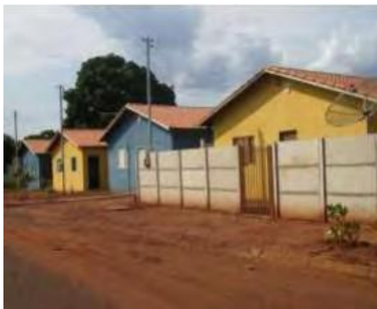
Figura 37. Rua sem pavimentação em São Simão - GO.
