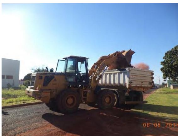
Figura 151 - Coleta de Entulho
