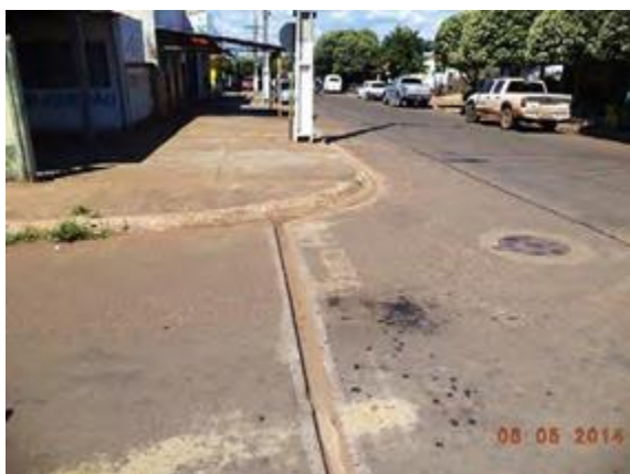
Figura 132. Vista geral da canaleta.
