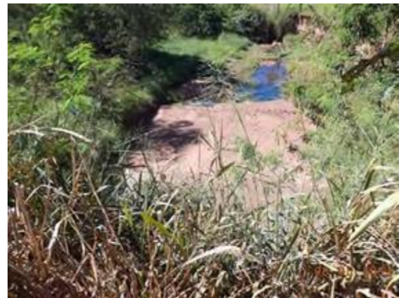
Figura 122. Detalhe da obra a jusante no córrego Colombo.
