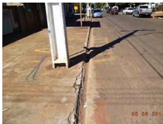
Figura 133. Canaleta no bordo da rua.
