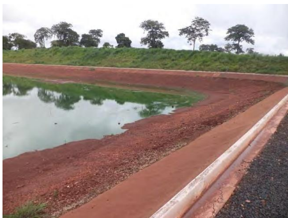
Figura 106. Talude e fundo da lagoa de estabilização.
