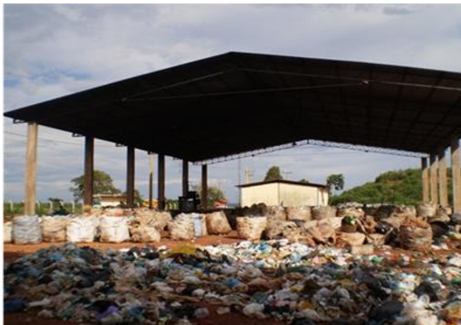
Figura 154 - Galpão para triagem e armazenamento de materiais recicláveis no Aterro Municipal de São Simão.
