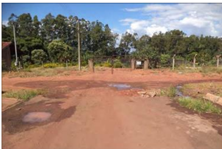
Figura 127. Interseção das Rua 22 com a Rua 20-A.
