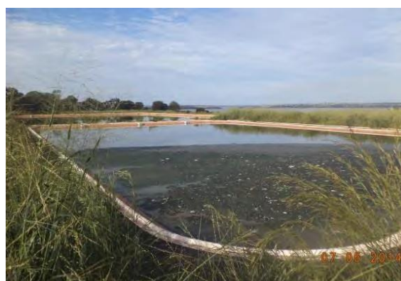
Figura 30. Lagoa facultativa e lagoa anaeróbia em operação.
