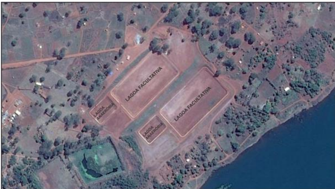
Figura 105. Imagem da ETE. Fonte: Google Earth (2015).
