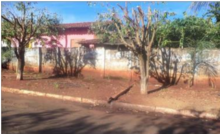
Figura 90. Lançamento de esgoto no logradouro público.
