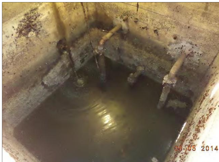
Figura 93. Vista interna do poço de sucção.
