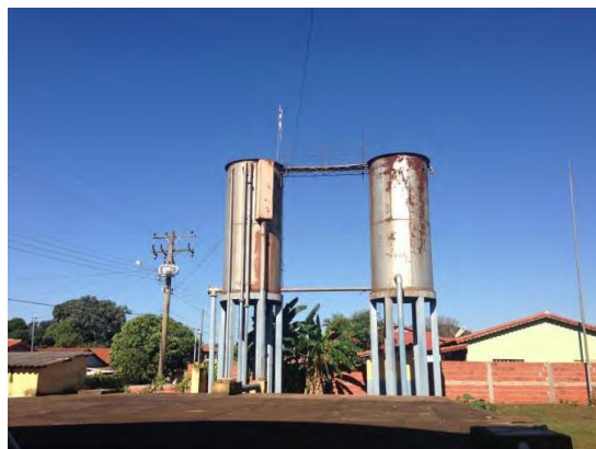
Figura 53. Reservatórios 74-A e 74-B.
