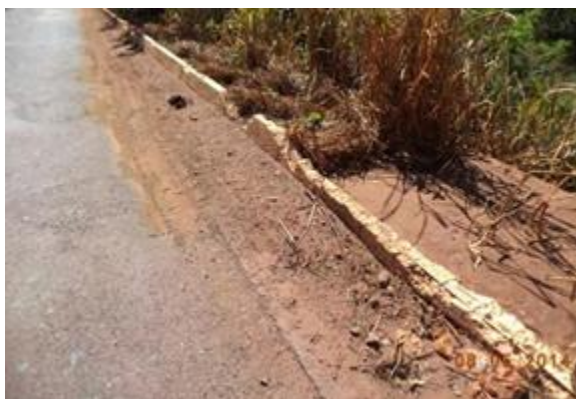
Figura 138. Meio fio obstruído.
