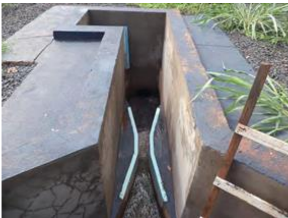
Figura 98. Calha Parshall.
