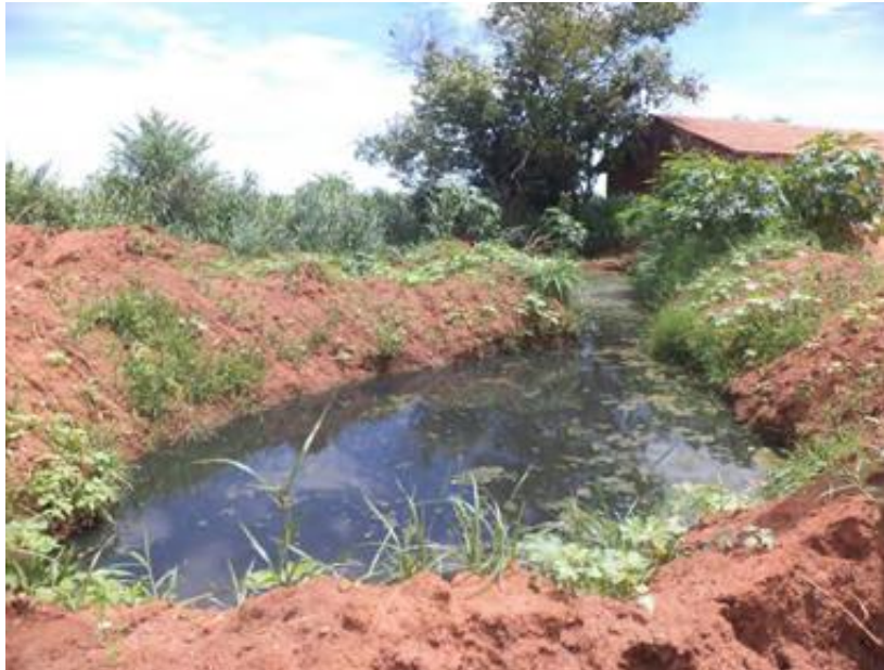
Figura 94. Lagoa de acumulação de efluentes no St. Comercial Sul, nas proximidades da BR-364.
