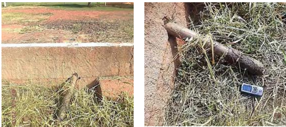
Figura 135. Detalhe do lançamento.
