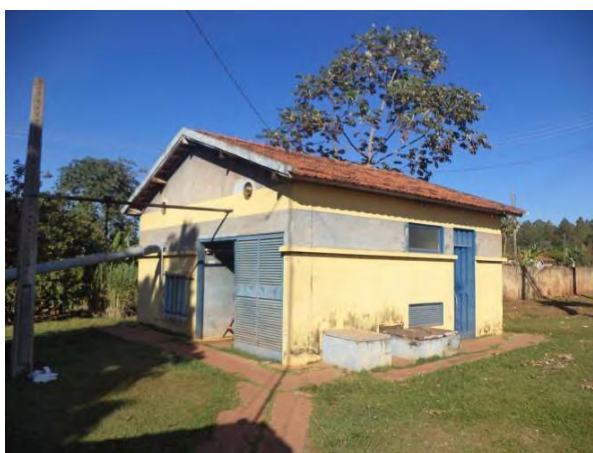
Figura 80. Casa de Recalque.
