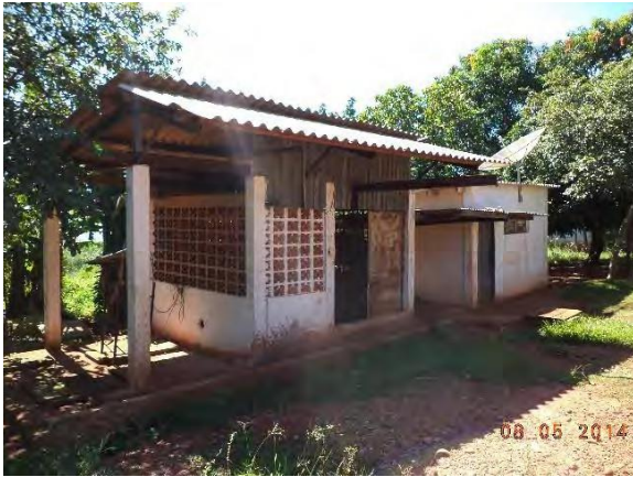
Figura 91. Vista externa da casa de bomba / manobra.
