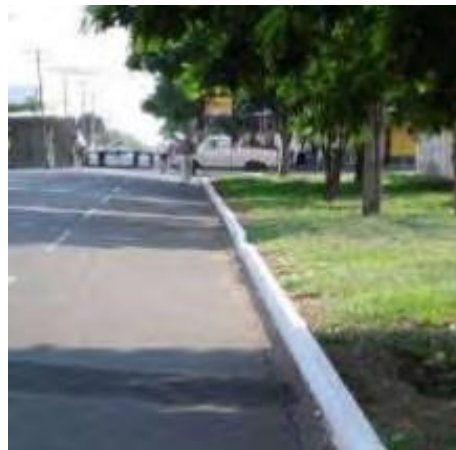
Figura 38. Rua com pavimentação asfáltica em São Simão - GO.
