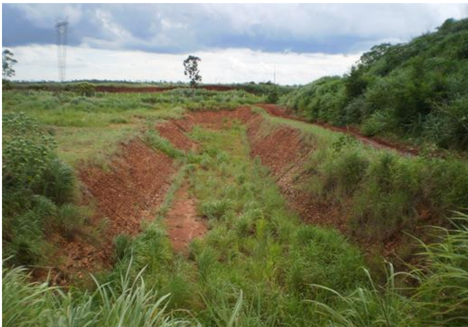
Figura 160 - Trincheira escavada no Aterro Municipal de São Simão.
