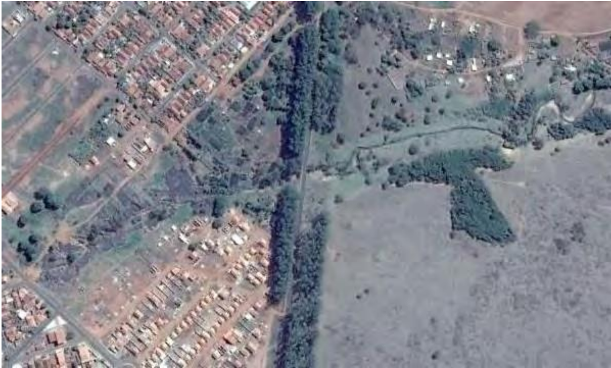
Figura 120. Obra de infraestrutura no córrego Colombo.
