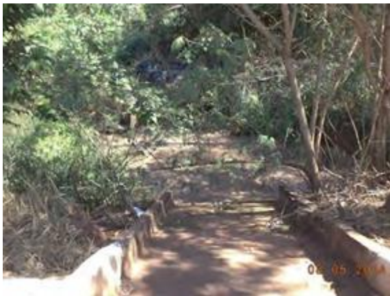
Figura 121. Detalhe da sarjeta no córrego Colombo.
