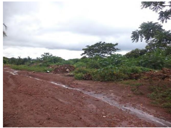
Figura 179 - Área de disposição de resíduos da construção civil.
