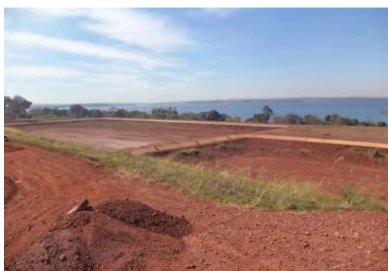
Figura 29. Lagoa facultativa e lagoa anaeróbia em fase de implantação.
