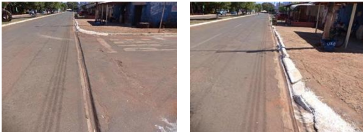
Figura 134. Canaleta no bordo da rua.
