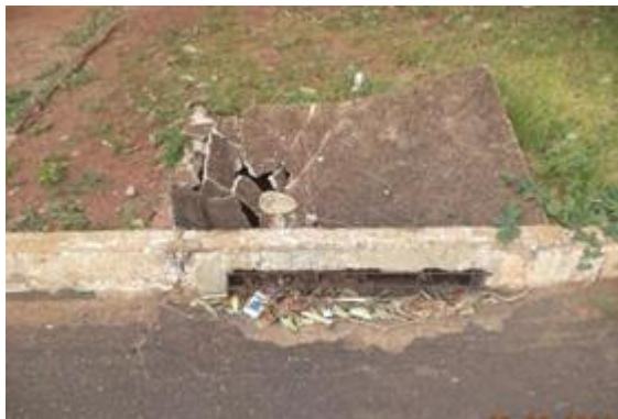
Figura 125. São Simão - coletor sem manutenção.
