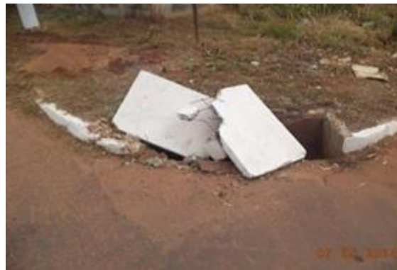
Figura 125. São Simão - coletor sem manutenção.
