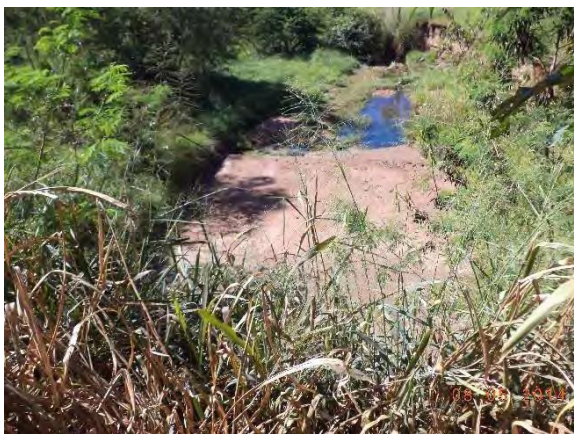
Figura 201. Movimentação de terra nas margens do córrego Pateirinho.
